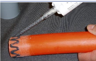
Apply BonDuit Adhesive
