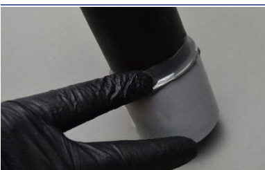
Smoothing BonDuit on coupling
