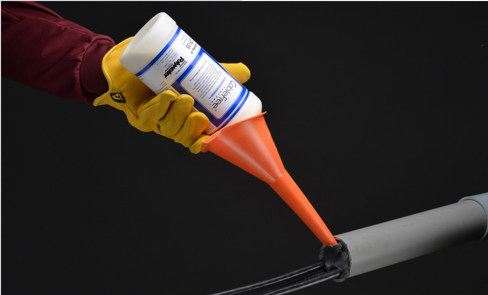
Pouring CableFree Loosener into the conduit
